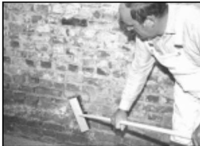
**Рисунок 8** - Удаление непрочных участков в гидроизолируемой поверхности.
