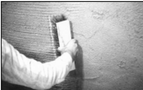
**Рисунок 12** - Нанесение первого слоя гидроизоляции.
