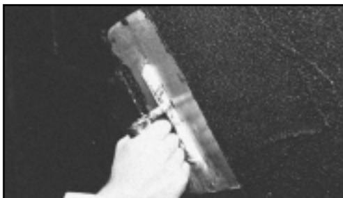
**Рисунок 13** - Нанесение третьего слоя гидроизоляции.
