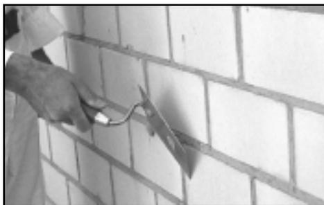
**Рисунок 9** - Подготовка кирпичной поверхности, очистка выступающего из швов раствора.
