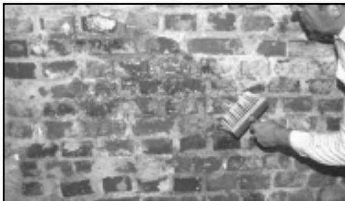
**Рисунок 10** - Нанесение грунтовки с помощью кисти.
