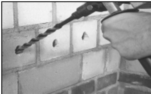
**Рисунок 14** - Подготовка конструкции под гидрофобизацию.
